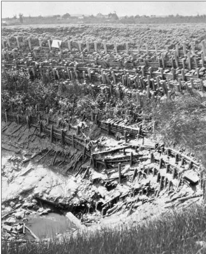
**Figure 2-27** Vue d'un aboiteau du XIX<sup>e</sup> siècle; la photo montre la structure très complexe nécessaire pour que l'aboiteau puisse résister à l'assaut des marées et des vagues.
