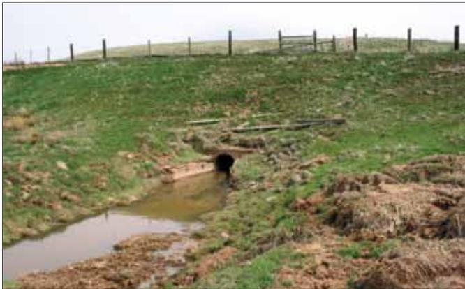
Figure 2-6 Un aboiteau toujours fonctionnel draine l'eau du marais.
