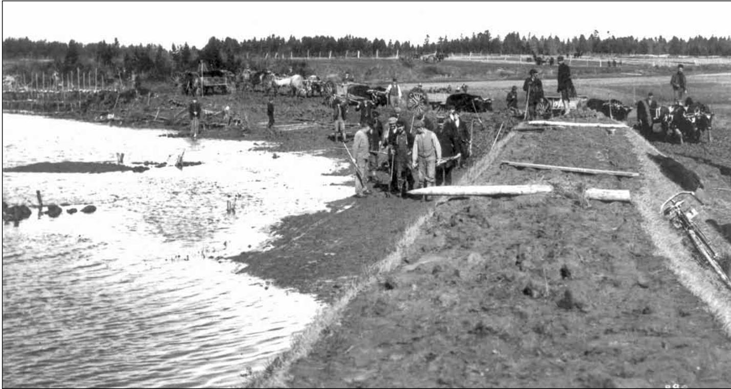
**Figure 2-36** La réparation des digues à Grand-Pré (env. 1900). La tradition voulant que l'on répare et entretienne les digues collectivement est née avec les Acadiens et s'est poursuivie avec les Planters de la Nouvelle-Angleterre, puis avec les générations de fermiers qui leur ont succédé.
