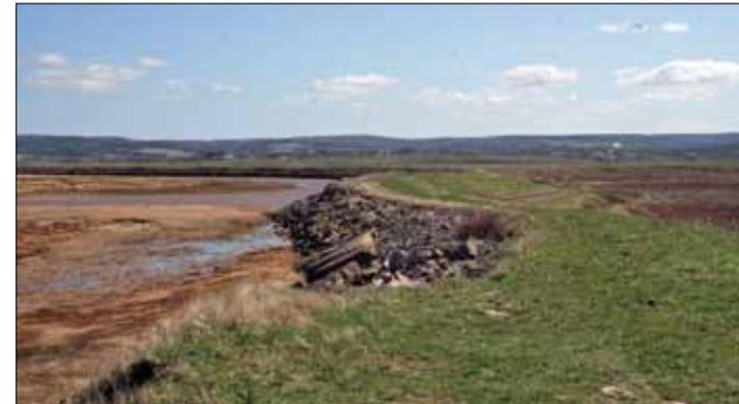
**Figure 2-5** Les digues de Grand-Pré ont des parements de roches qui les aident à résister à la force des marées et des tempêtes.
