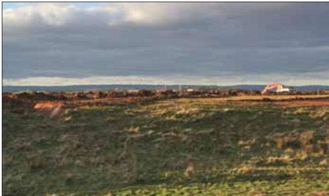
Figure 2-54 Depuis les années 1970, on applique à Grand-Pré une technique de terrassement de mise à niveau ou de remodelage de la surface du marais en vue d'en améliorer le drainage.
